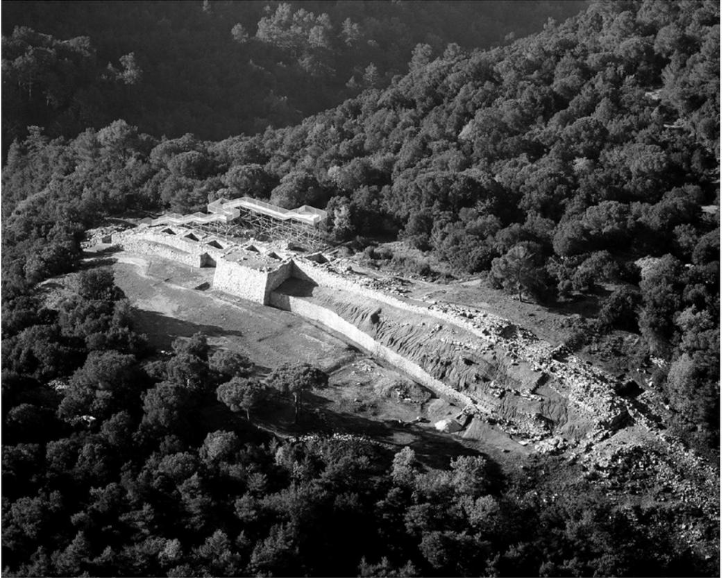
La muralla del siglo IV a. C. es un muro alargado de diferentes anchuras, construido por fases. Cada cambio de anchura se corresponde con una fase que se identifica por una junta constructiva. La muralla tiene tres bastiones y en el tramo meridional, seis cuerpos de guardia.
