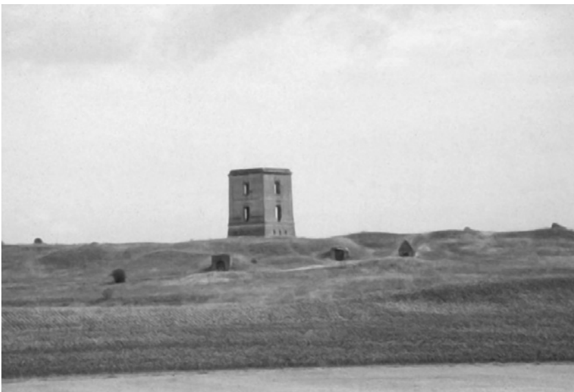
Figura 1. Torre de telegrafía óptica de Codorniz, en la provincia de Segovia.
